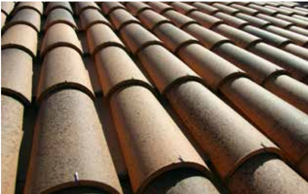
Pormenor de fixação de telha canudo
