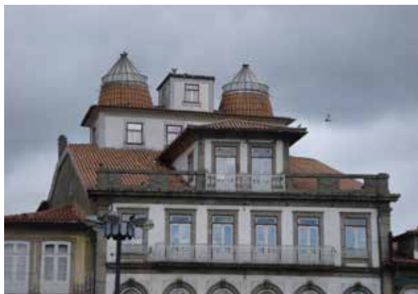
Telhados de múltiplas águas e geometria complexa
