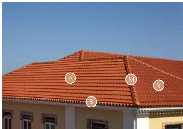
Água mestra (A), rincão ou guieiro (M), tacaniça (N) e beirado (B)
