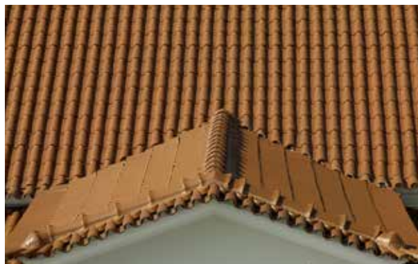
Pormenor de telhado com telha lusa
