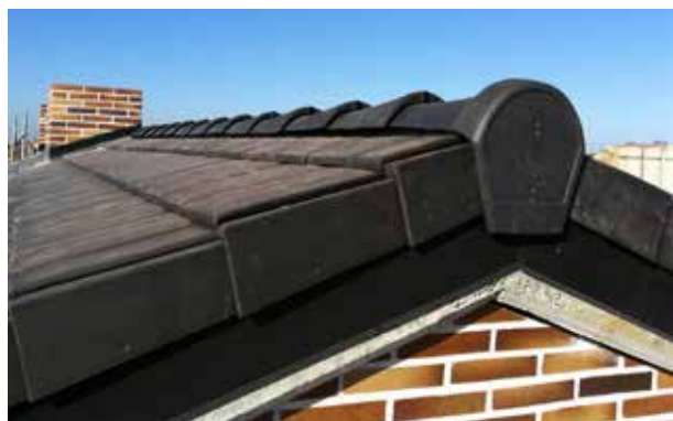
Pormenor do remate da empena da telha
