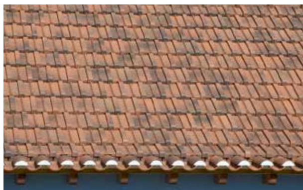
Telha marseille com beirado
