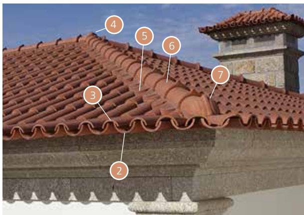
Pormenor de beirado com cimalha
