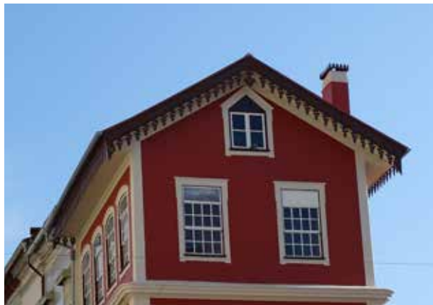
Telhados de 2 e 4 águas
