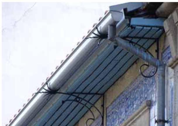
Algeroz exterior (metálico) e interior (pedra)
