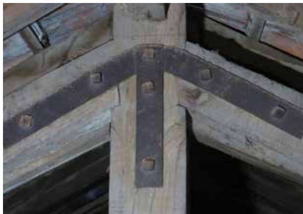
Nó com reforço metálico
