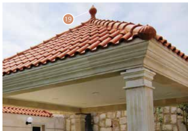
Beiral e rincão com telha lusa e terminação com pirâmide
