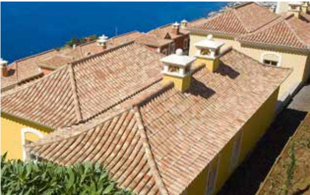
Vista geral de telhado com telha canudo
