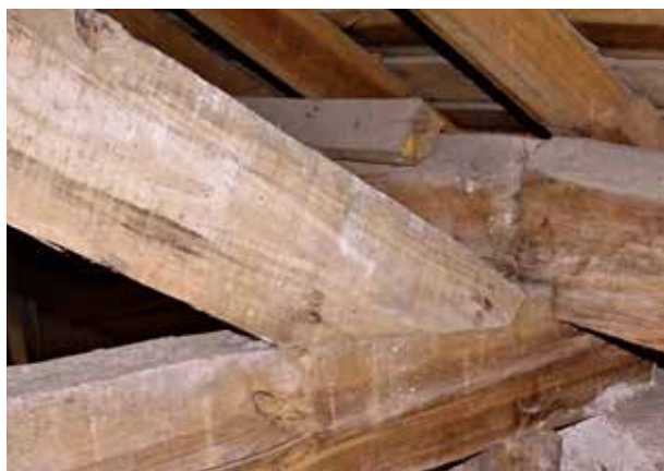
Ligação perna-linha do tipo simples
