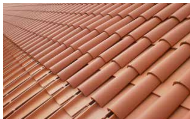
Pormenor de fixação de telha romana
